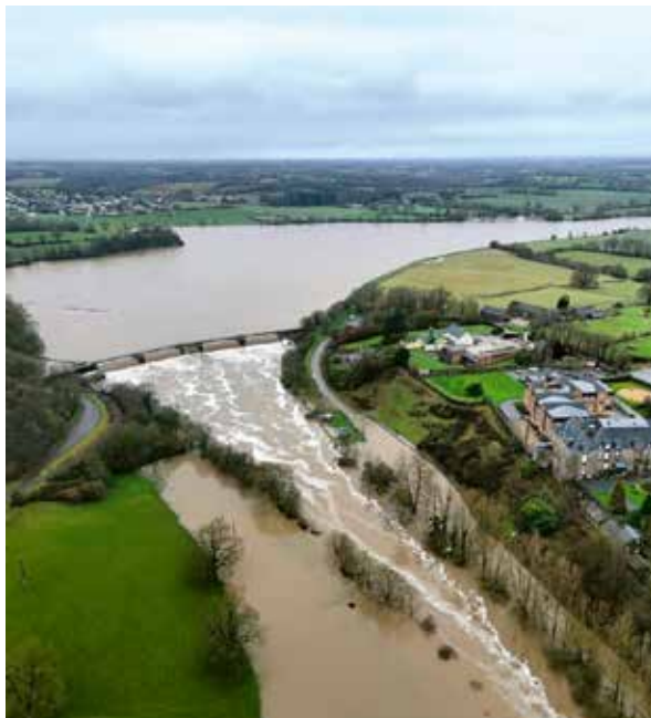
▲ Vue du barrage sur le lac de Haute-Mayenne lors des crues de cet hiver.
