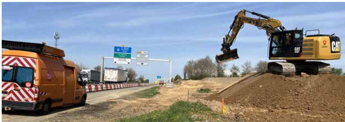
▲ Les travaux ont démarré le 31 mars dernier.
