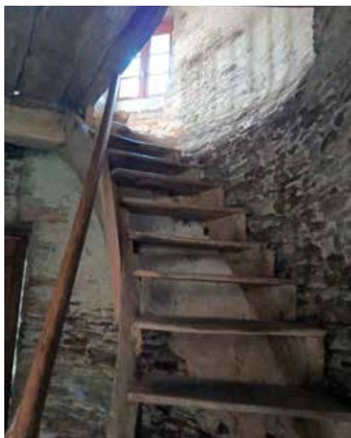
▲ Escaliers, planchers, charpentes... Le bois est omniprésent, dans le fût de la tour de pierre.
