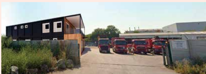
▲ À gauche, perspective finale du nouveau bâtiment en cours de construction.
