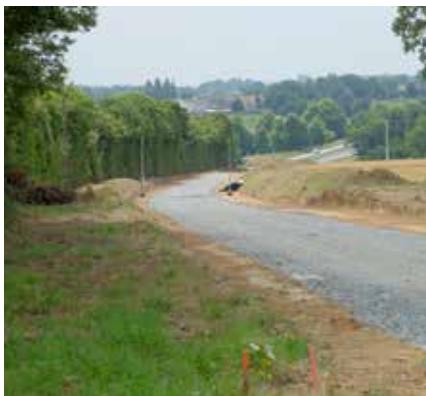
▲ Les travaux se poursuivent.
