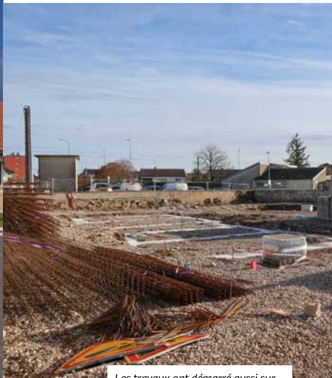
Les travaux ont démarré aussi sur le terrain en friche du carrefour
