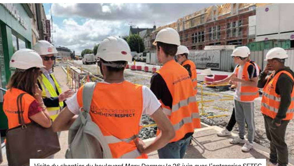
Visite du chantier du boulevard Marx Dormoy le 26 juin avec l'entreprise SETEC
