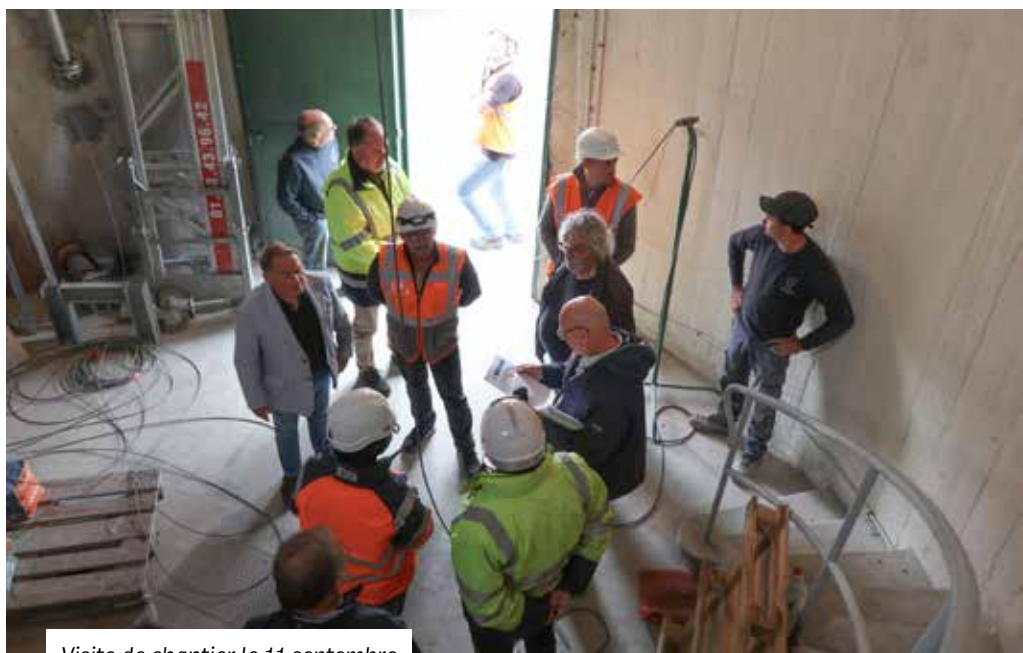
Visite de chantier le 11 septembre
