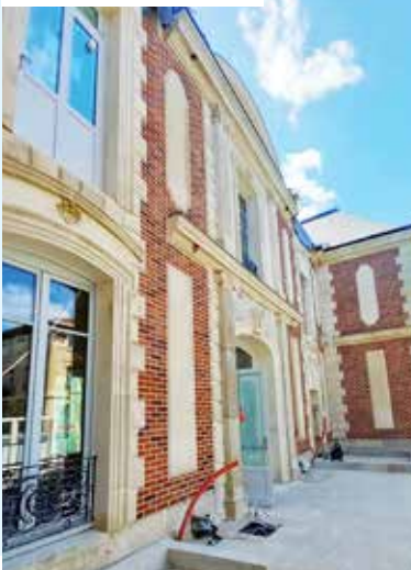
l'Hôtel de Ville en travaux
