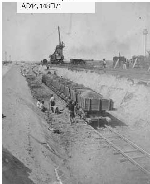
Construction de la nouvelle écluse de Ouistreham avec un excavateur, 1896. AD14, 148FI/1
