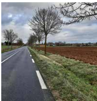
RD511 au sud de Vendevre avant aménagement d'une voie verte latérale.
