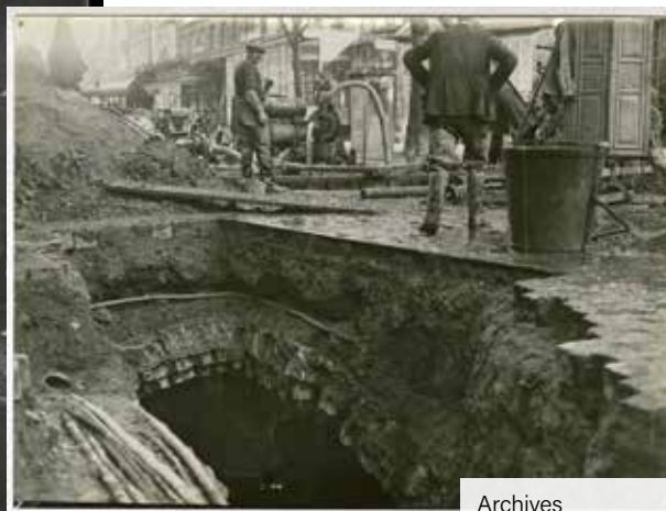
Archives du Calvados, 21Fi/6, travaux d'installation des nouveaux égouts à Caen, boulevard des Alliés, 1934
