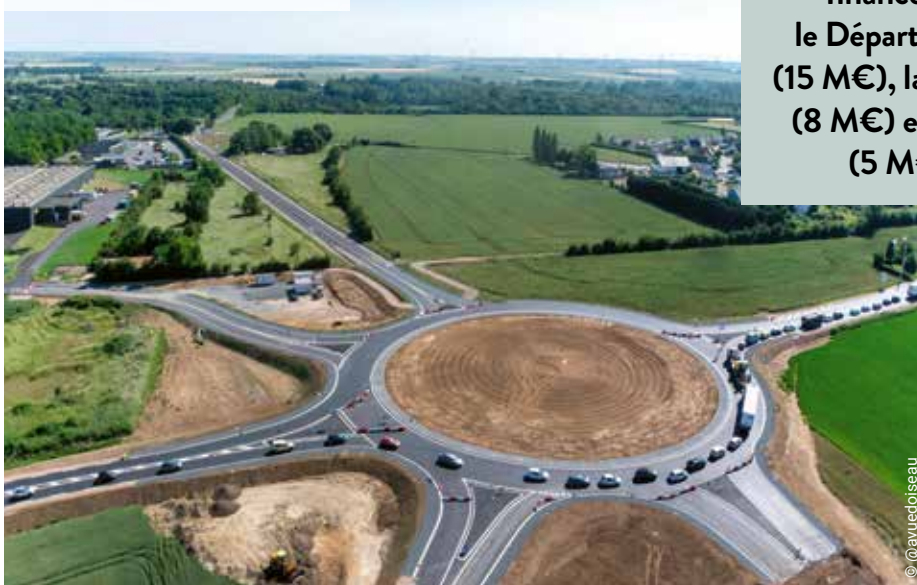
Nouveau carrefour giratoire sur la RD 613, à l'est de Vimont.
