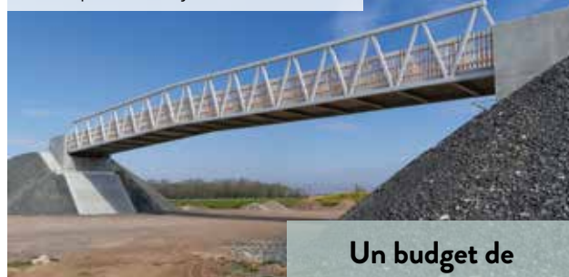
Passerelle piétons et cycles sur la RD 41.
