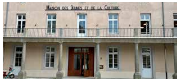
Seconde tranche des travaux de la MJC 1,02 M€
