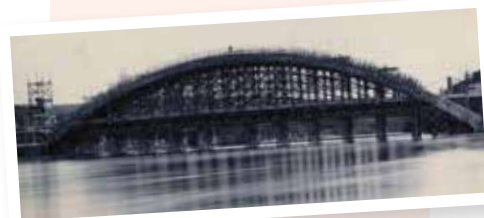
Photographie représentant le pont de Bas-en-Basset en construction, 17 avril 1932 [Arch. dép. Haute-Loire, 7 Fi Bas 1/1]
