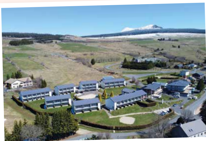
Le VVF avant le chantier.
