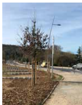
Chantier des entrées de villes
