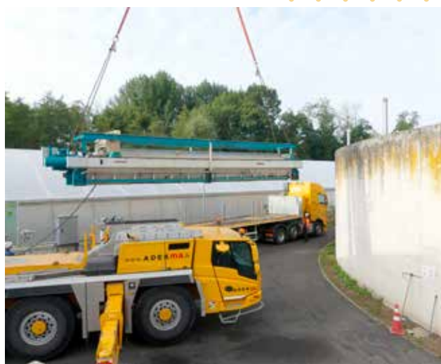
Opération de démontage de la toiture et du filtre à bande pour évacuation sur convoi exceptionnel
