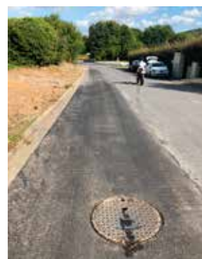
Extension du réseau EU et renforcement AEP chemin dit du Fourneau
