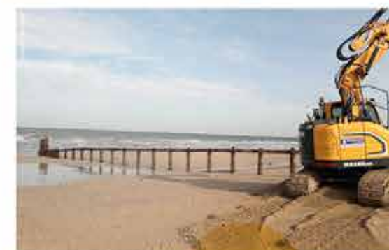
Travaux de préservation du littoral.
