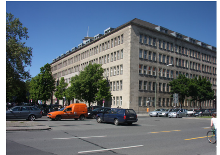
Ansicht des Gebäudes Fehrbelliner Platz 1
