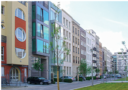
Abb. 37: Townhäuser am Werderschen Markt in Mitte
