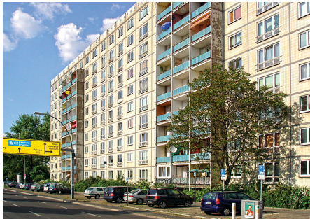
Abb. 47: Betonplattenbauten des komplexen Wohnungsbaus
