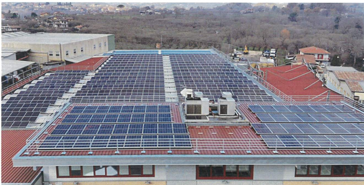
Foto n° 2 - Opificio Agroindustriale TERMINIO FRUTTA E ALIMENTARI di Gaetano De Feo & C sas Impianto fotovoltaico installato di 498,42 KW
