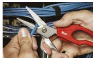
Garganta de cables que impide el paso
