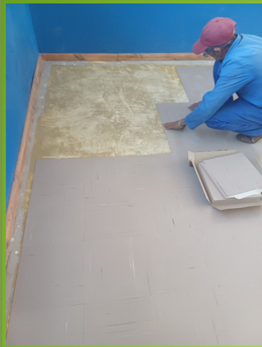
Teëlwerk byna voltooi. Plafonplate word aan brandering vasgeboor
