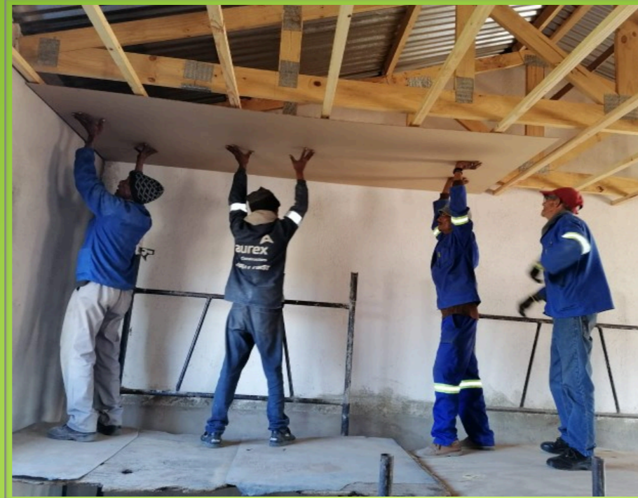
Teëlwerk byna voltooi. Plafonplate word aan brandering vasgeboor
