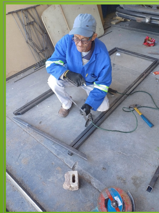
Oom Koos besig om veiligheidshek te maak. Hy hang ook klaskamer deur Verfwerk begin in die binne- en buitekant van die klaskamer
