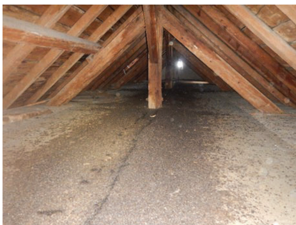
Combles avant nettoyage
