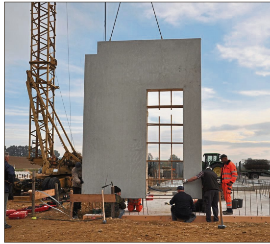
Im Rohbau erkennt man das Prinzip des Gebäudes – links das Gerätehaus, rechts der Bauhof. Mit ihrem großen Arbeitseinsatz – die Bilder zeigen den Einbau der Betonfertigteile und den Innenausbau – senkten die Feuerwehrleute die Kosten für das Bauwerk erheblich. Gleichzeitig wuchs der Zusammenhalt untereinander.
