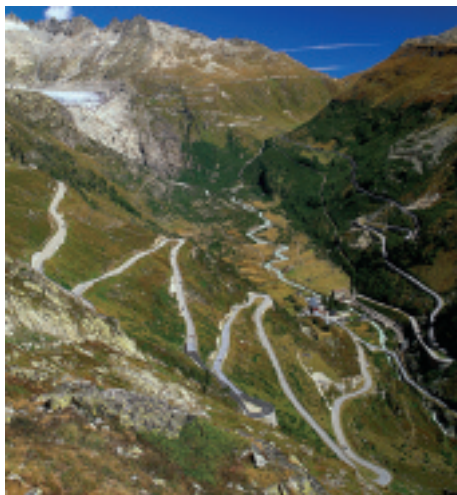
Para subir montanhas elevadas as estradas são geralmente em zigue-zague de modo a que a inclinação não fique demasiado acentuada.
