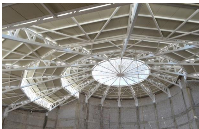
Techo de la Iglesia de San Lorenzo
