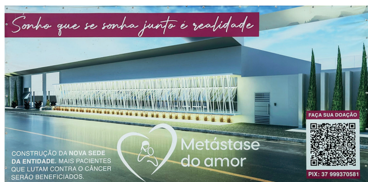
Obras da futura nova sede da Metástase do Amor. Foto: David Fragoso
