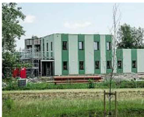
Impalcature Una di quelle più indietro con i lavori è quella che sarà aperta a Marcon (Rbmultimedia)
