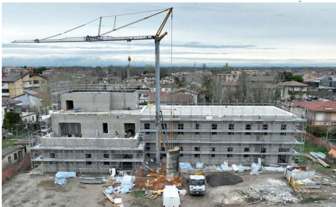
LAVORI IN CORSO IL CANTIERE PER LA CASA DI COMUNITÀ CHE SI STA REALIZZANDO A MIRA
