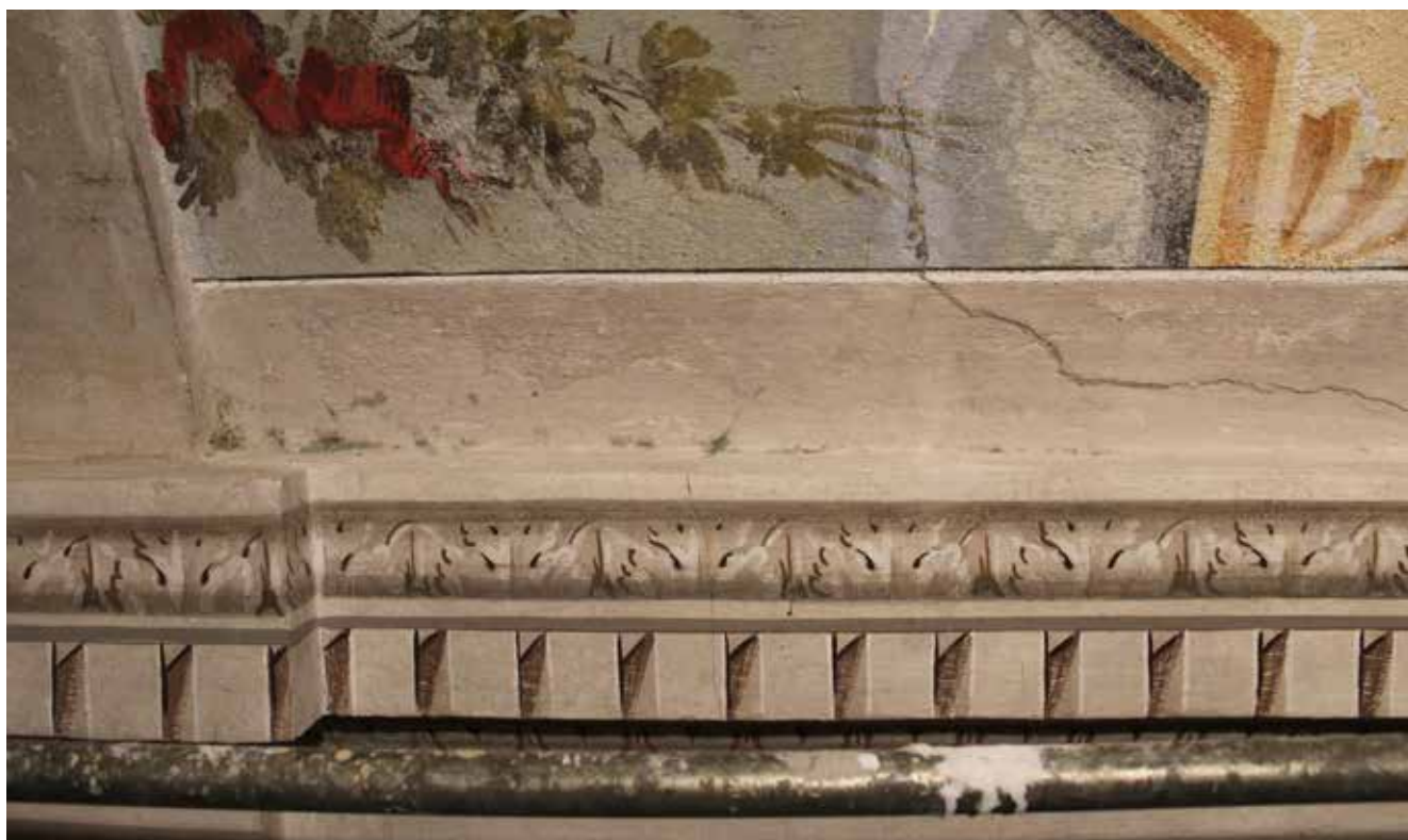
2. Intonaci decorati della volta: colonizzazione biologica.
