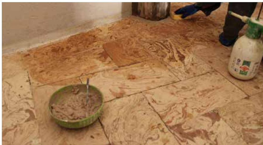
A LATO_11. Pavimento in cotto della galleria durante l'operazione di stuccatura. SOTTO_12. Palco reale: particolare durante l'operazione di stuccatura.
