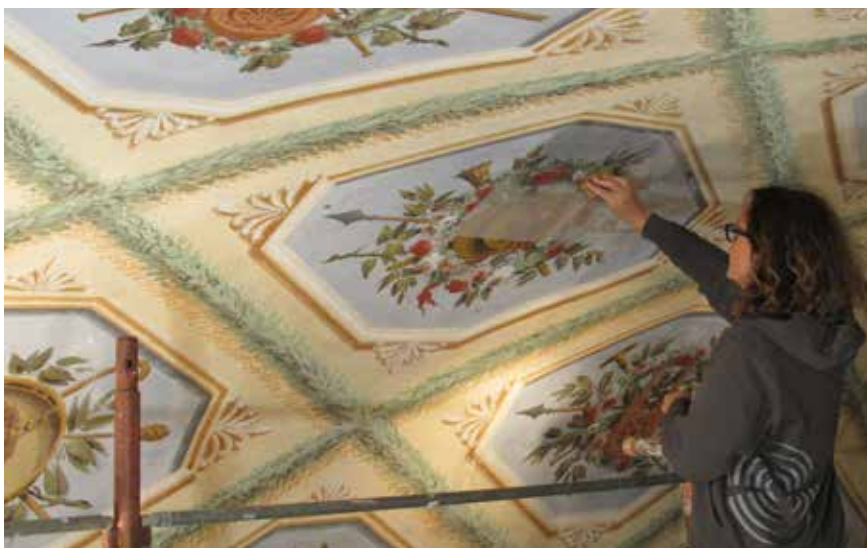
IN APERTURA_ Veduta d'insieme della sala teatrale (Archivio Consorzio villa Reale e Parco di Monza). 1a,b. Intonaci decorati: operazione di pulitura e vista della sala verso il palco reale dopo il restauro (ph. Andrea Basci per Cooperativa per il Restauro).
