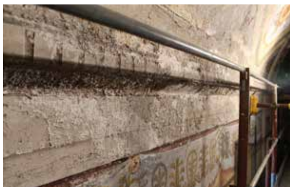
2. Intonaci decorati della volta: colonizzazione biologica.
