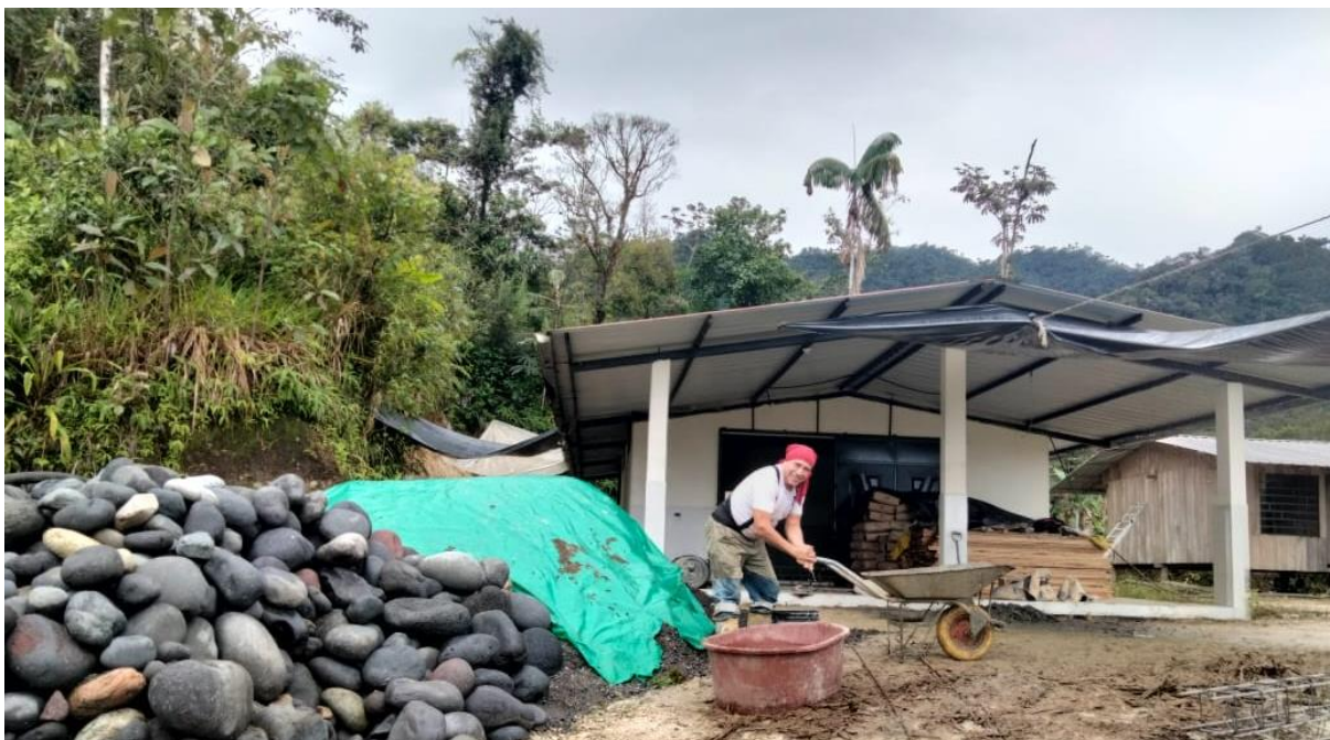
In Juni 2025 zijn we begonnen om het bestaande gebouw om te bouwen tot quarantaine.
