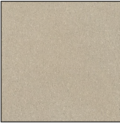
Fassade Haupteingang Verputzt 1mm Farbe KABE 132
