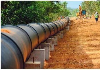
Obra em construção para o sistema de saneamento de São Paulo, com o lançamento de uma das grandes tubulações.
