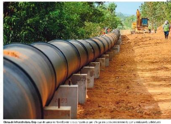
Operação de instalação de uma rede de distribuição de gás em uma obra de infraestrutura.
