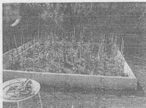
Vasoio assorbente : fase di ultimazione e piantumazione di piante idrofile
