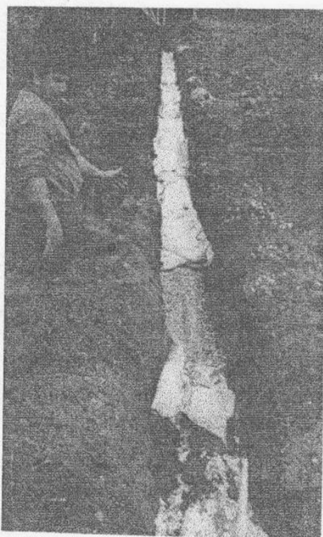
Condotta disperdente al suolo continua in P.V.C. pesante (lunghezza ml. 40)
