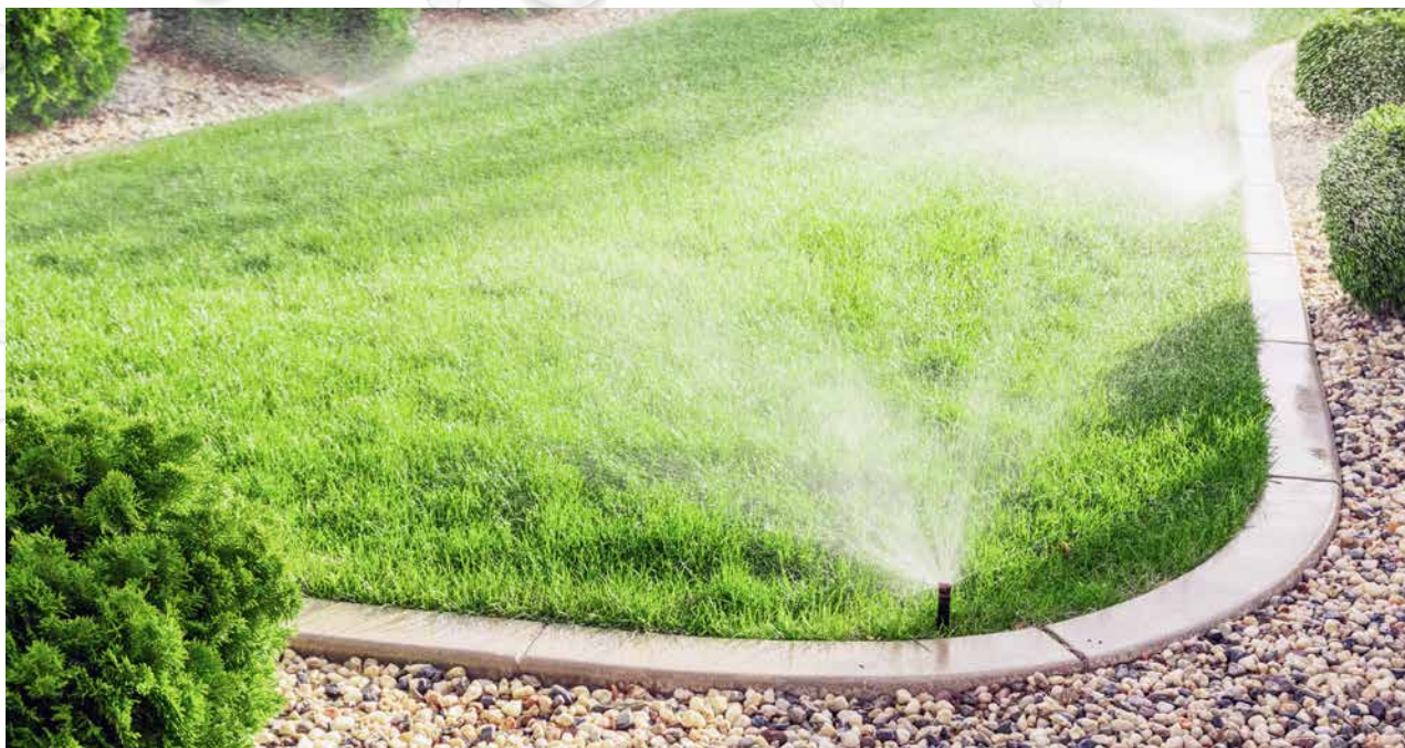
Versenkregner für Rasenbewässerung: Je nach Winkel, Fläche und Wasserdruck kommen verschiedene Modelle zum Einsatz. Professionelle Modelle können so eingestellt werden, dass das Wasser in jede Ecke gelangt, ohne auf Nebenflächen zu spritzen.
