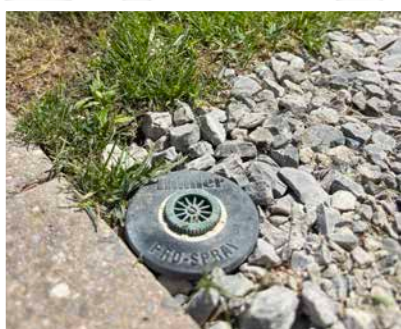
Versenkregner für Rasenbewässerung: Je nach Winkel, Fläche und Wasserdruck kommen verschiedene Modelle zum Einsatz. Professionelle Modelle können so eingestellt werden, dass das Wasser in jede Ecke gelangt, ohne auf Nebenflächen zu spritzen.
