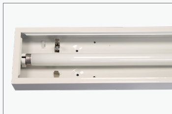
Schritt 1 bestehendes Leuchtmittel entfernen
