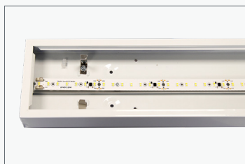
Schritt 3 neuen LED-Konverter 24V DC in der Leuchte montieren (z. B. mit doppelseitigem Klebeband)
