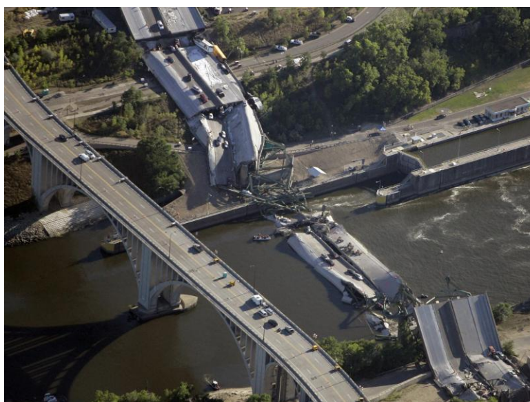
Figura 7 - Vista aérea do colapso da ponte I-35W em Minneapolis, 2007. A investigação apontou a falha em uma chapa de ligação subdimensionada como o gatilho para o colapso. Fonte: NTSB.
