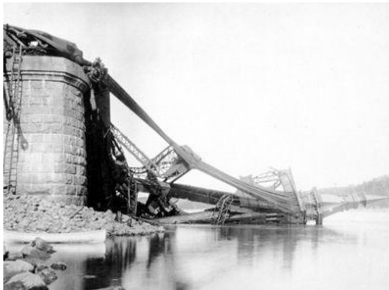
Figura 8 - Ruínas da Ponte de Quebec após o colapso de 1907. A falha foi atribuída à flambagem dos membros inferiores de compressão, um erro crasso de projeto. Fonte: Library and Archives Canada.
