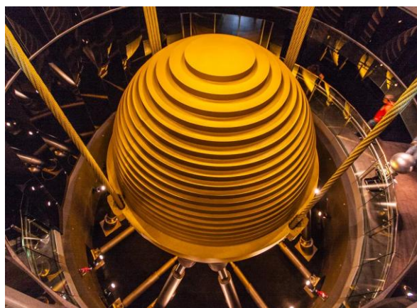
Figura 1 – TMD instalado no Taipei 101.
