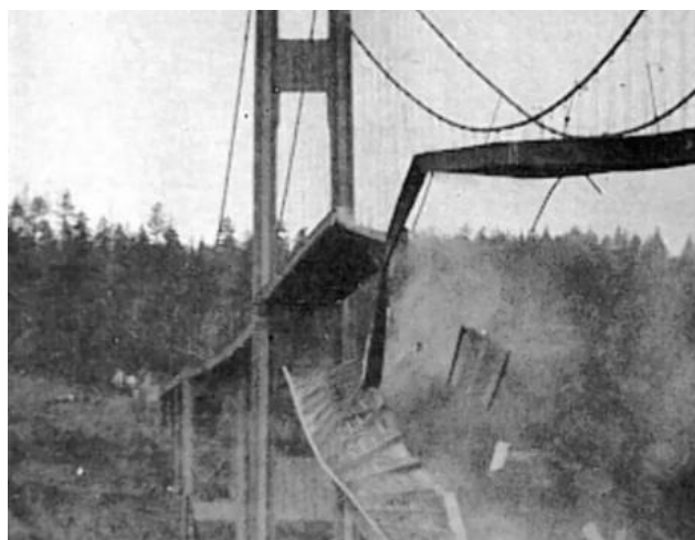
Figura 7 - Queda da ponte Tacoma Narrows Bridge.
