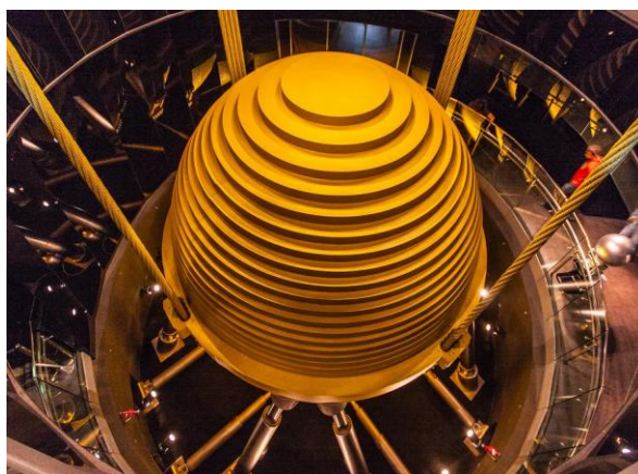
Figura 1 – TMD instalado no Taipei 101.
