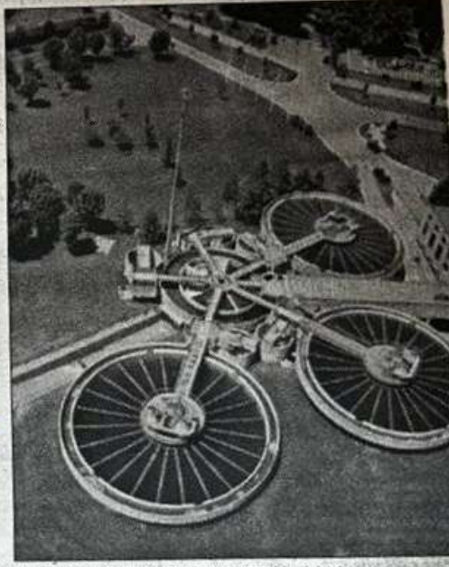
Un impianto dell'Azienda Acquedotto Municipale
