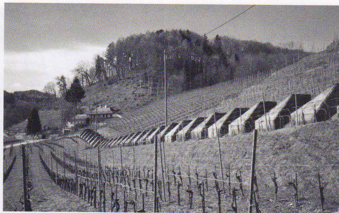
Barrage antichar «Terrains», secteur Sermaret.
