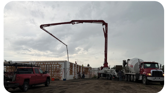
ICF Residence Wall Pour
