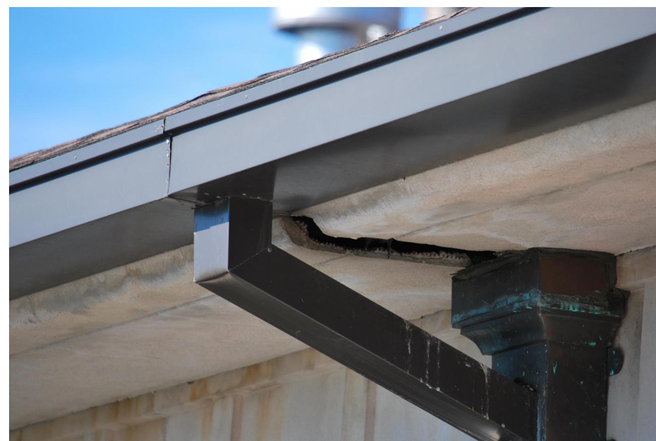
A1 ALT NO. 3: STUCCO SOFFIT REPAIR
