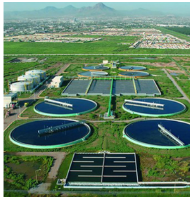
TRATAMIENTO DE AGUA
