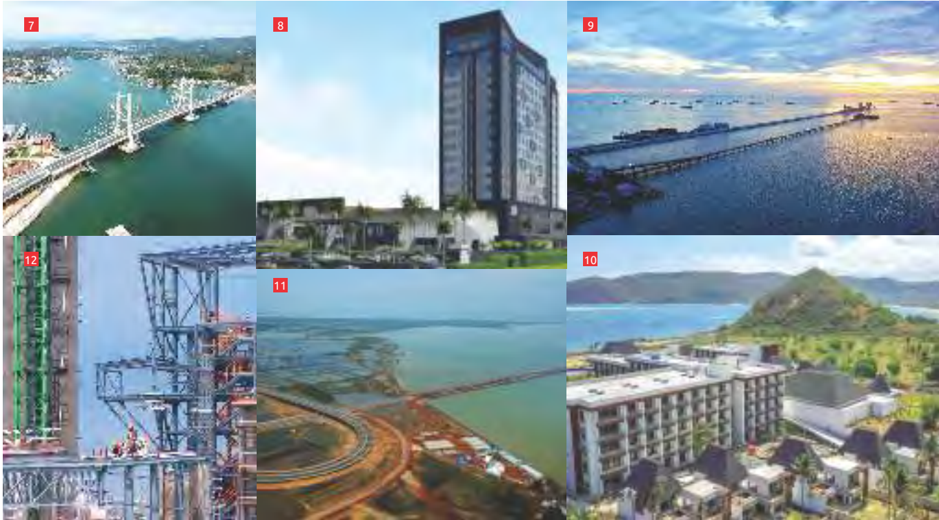
7 Jembatan Teluk Kendari, Kendari, Sulawesi Tenggara 12 HOLCIM Tuban, Jawa Timur
