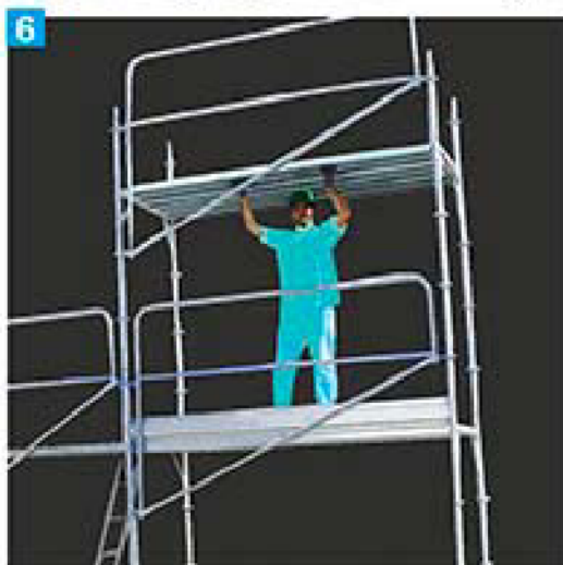
2 MONTAGGIO DELLE TAVOLE DA PONTE E CONTROVENTO Inner Tie-rod Assembly Upwind Scaffolding Boards Assemblage
