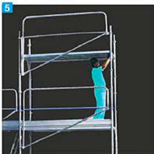
1 INNESTO DEGLI ELEMENTI SUPERIORI Inserting the higher parts
