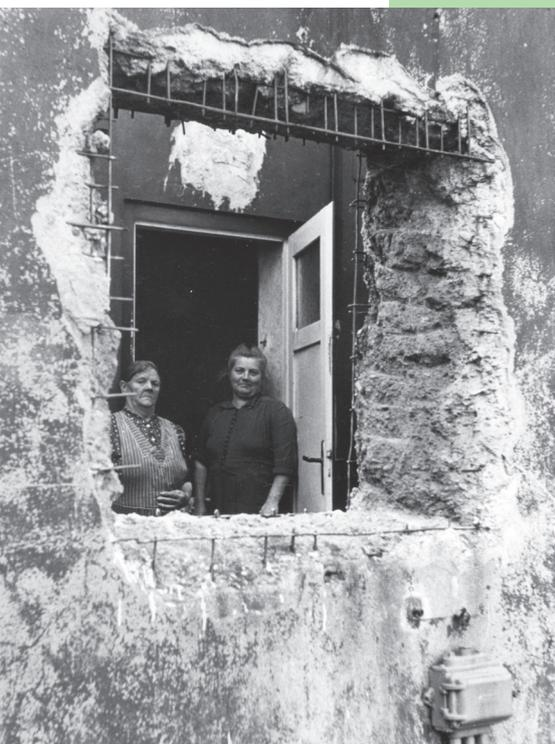
Abb. 3: Das Herausbrechen von Fensteröffnungen in den mächtigen Betonbauten brachte wenigstens etwas Licht in die Behausungen.
