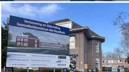
Verbouwing en uitbreiding Gezondheidscentrum 'Het Raadhuis' in volle gang
