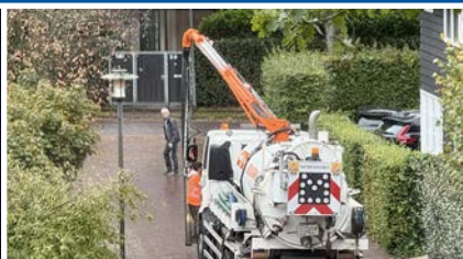
Rioolreiniging en inspectiewerkzaamheden
