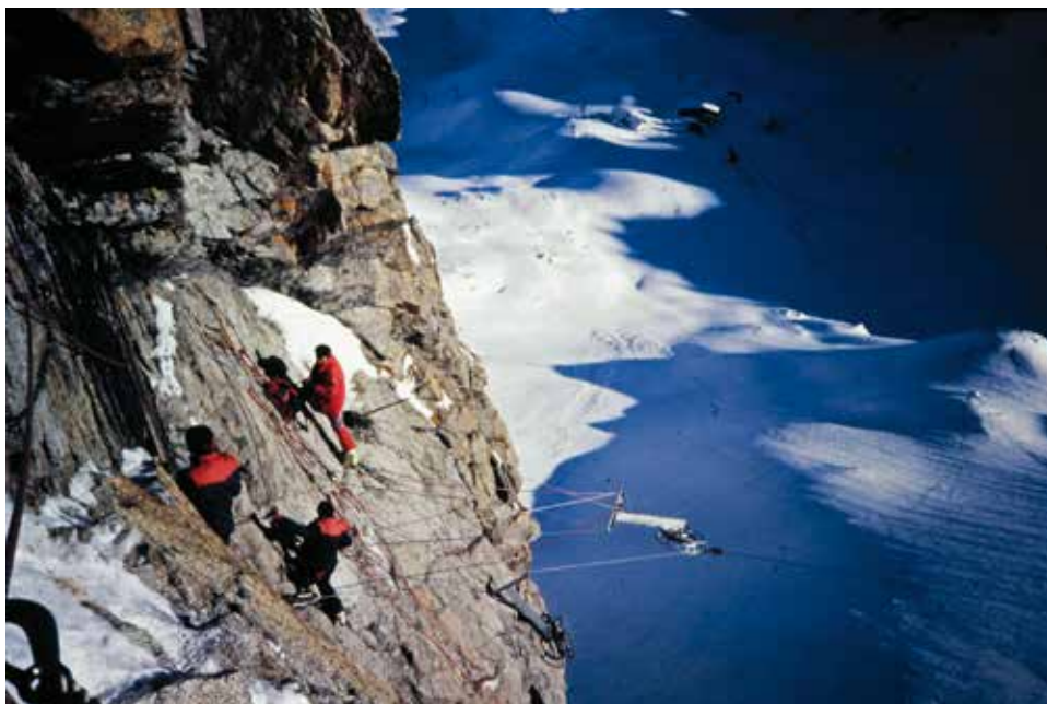
LE OPERAZIONI DI POSIZIONAMENTO DEL CATEX PER PROVOCARE IL DISTACCO DELLE MASSE NEVOSE A RISCHIO VALANGHE.
