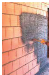
Spruzzatura pareti e intercapedini
