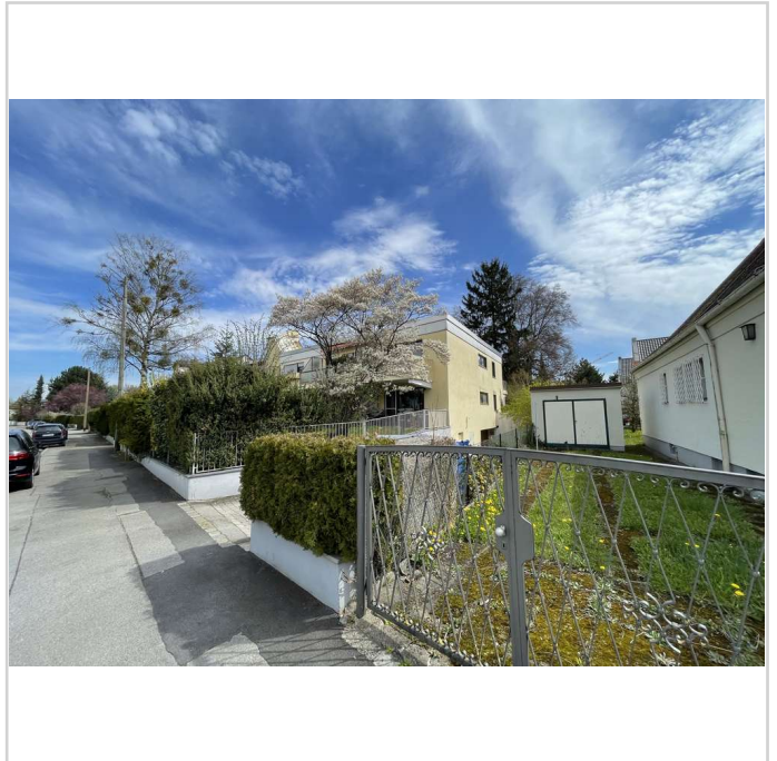
Hausansicht vor Renovierung
