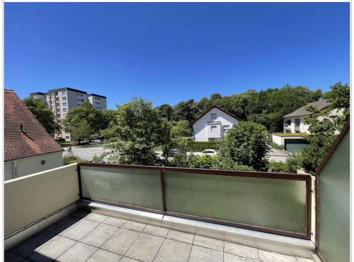
Ausblick WEST vor Renovierung
