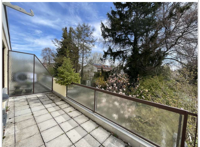
Terrasse OST vor Renovierung
